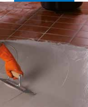
Stesura del secondo strato di Monolastic su Mapenet 150
